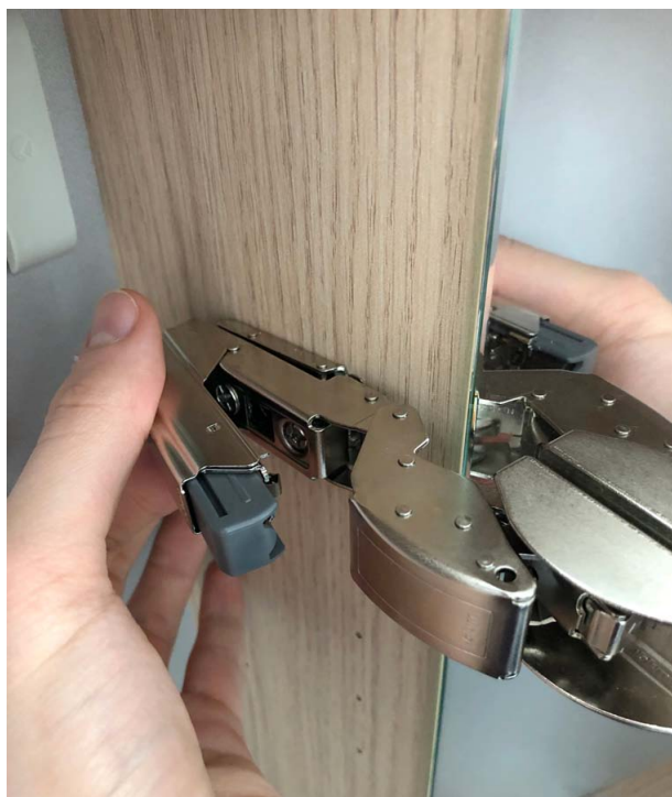
Abb. 4 | Montage von Glastürdämpfung und Abdeckkappe
