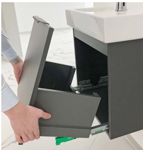
Korpusschienen ausziehen und den Auszug aufsetzen.
