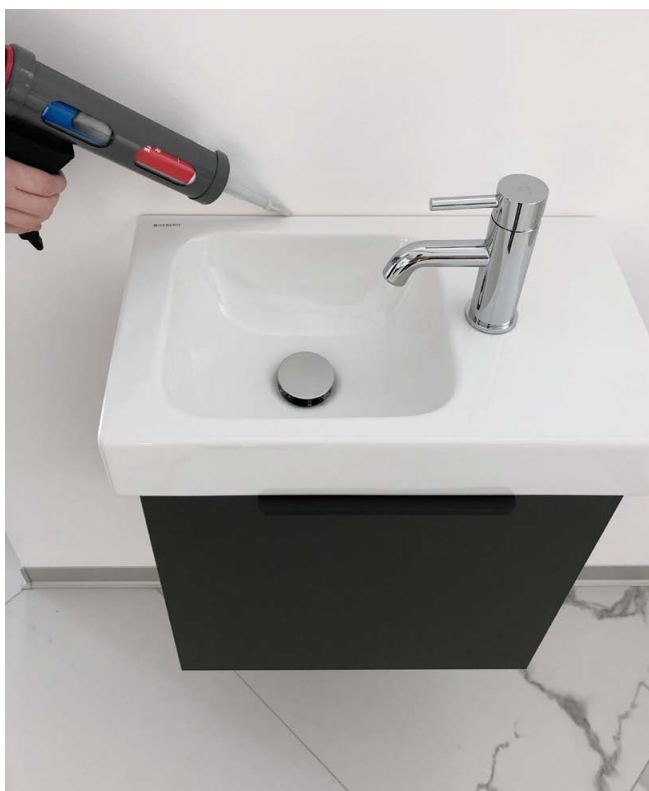
Abb. 6 | Waschtisch-Montage / Abdichten zur Wand mit Silikon
