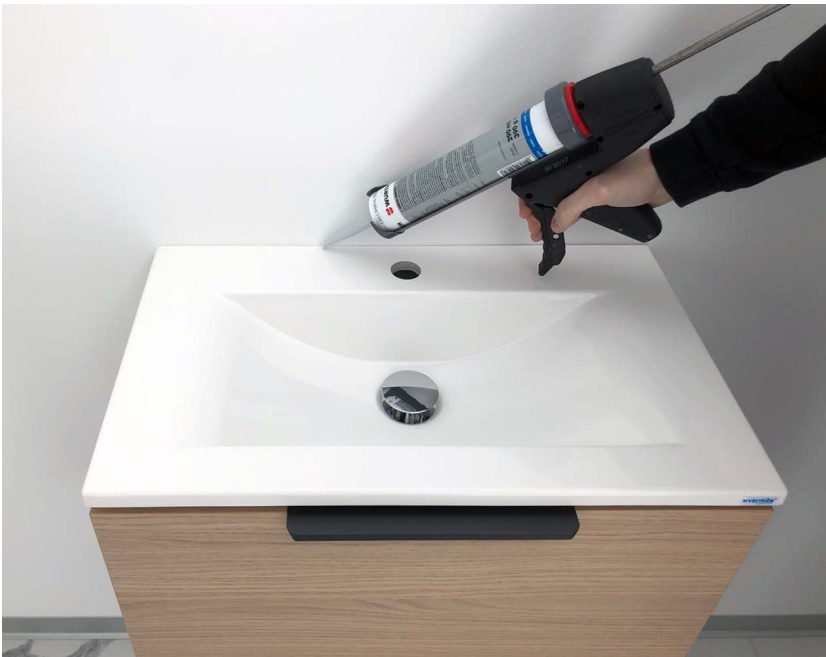
Abb. 4 | Waschtisch-Montage / Abdichten zur Wand mit Silikon
