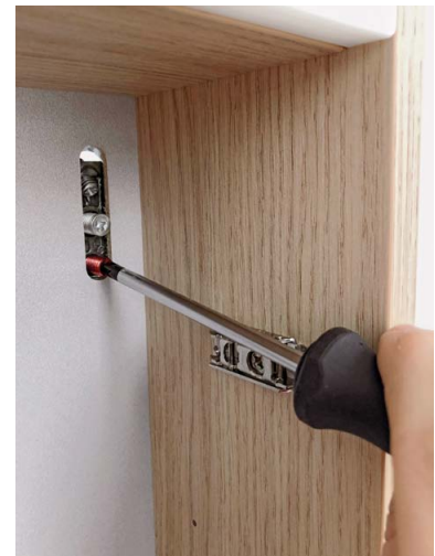
Fixierung an der Montageplatte
