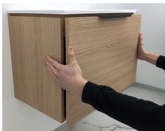
Auszug in den WT-Unterschrank ganz einschieben und andrücken bis ein „Klick“ zu hören ist – arretiert automatisch.
