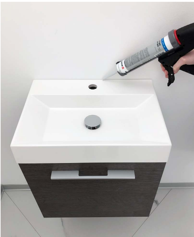
Abb. 6 | Waschtisch-Montage / Abdichten zur Wand mit Silikon
